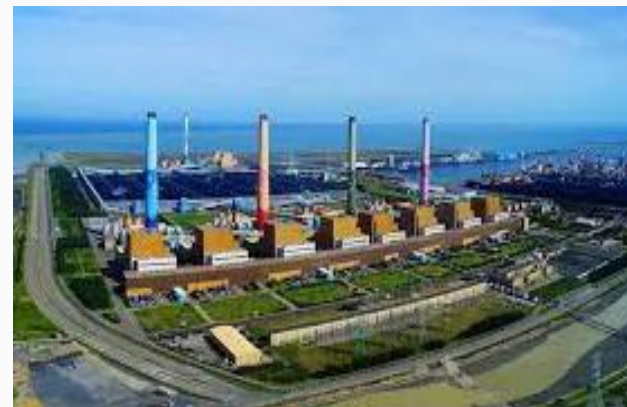
台中火力發電所-變電所
